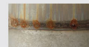
配管内部(溶接部)
