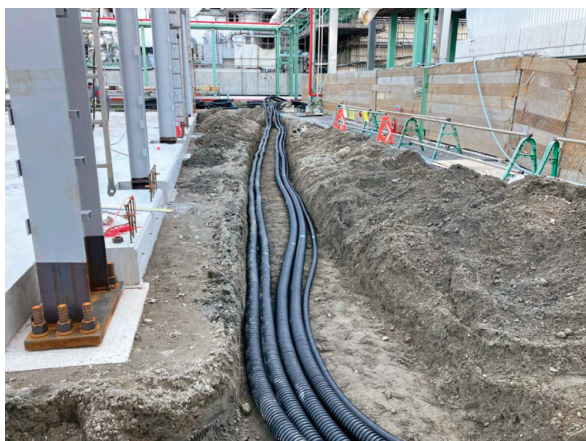
図2 FEP配管埋設状況
