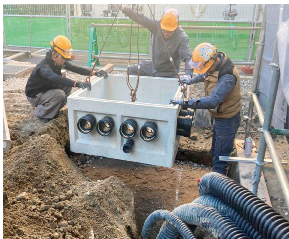
図3 ハンドホール設置状況
