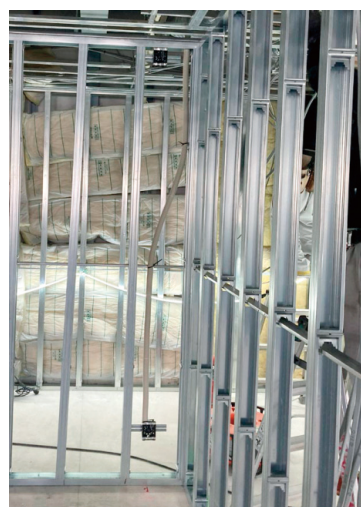
図5 埋込ボックスおよびPF管敷設状況
