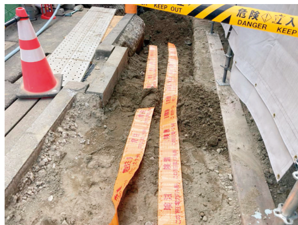
図4 埋設シート敷設状況
