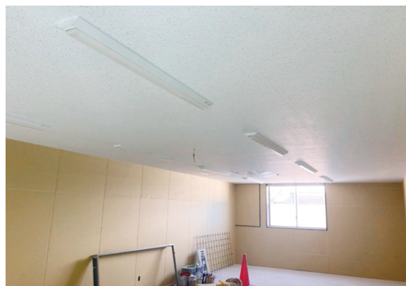
図8 照明取付状況
