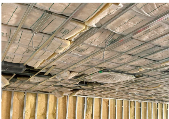
図6 照明事前配線敷設状況
