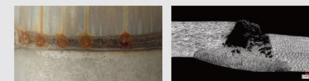
配管内部(溶接部)
