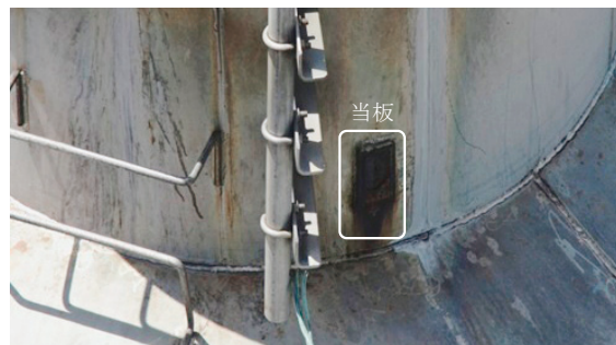
図7 避雷針取付部の拡大画像
