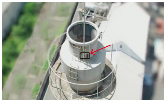
図6 煙突頭頂部の広角画像
