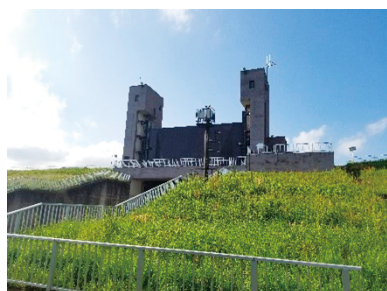
図1 河川のゲート設備
