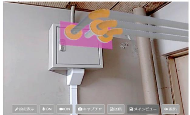
図9 配管と電気盤の干渉
