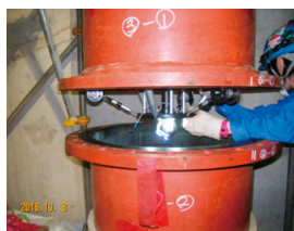
(a) 自走式ロボット取付作業
