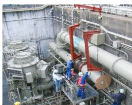
(b) 現地取付作業
