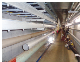
図3 既設配管取替作業
