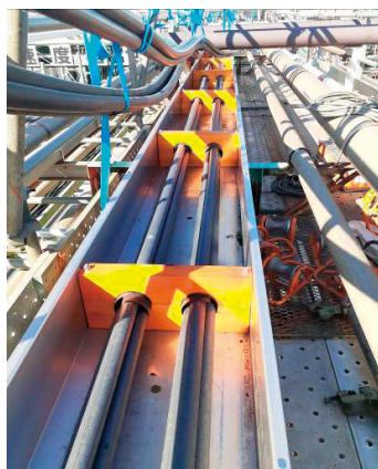
図5 ケーブルダクト内クリート取付状況
