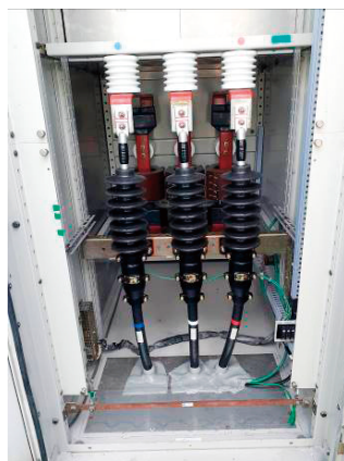
図6 ゴムとう管形端末処理
