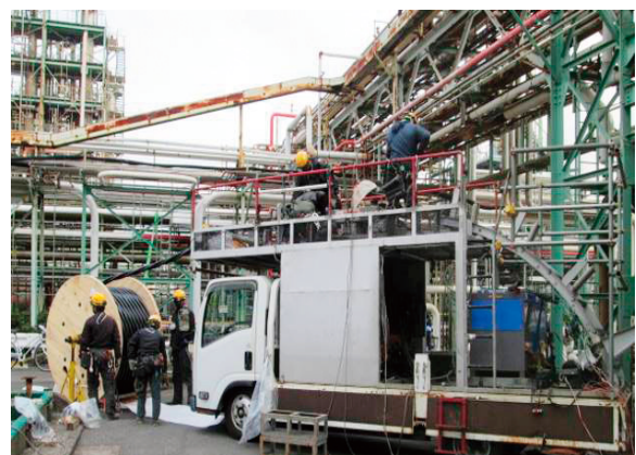
図4 ケーブル延線車での作業状況
