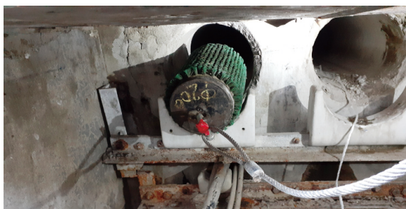
図2 管路導通点検用器具(ボビン)
