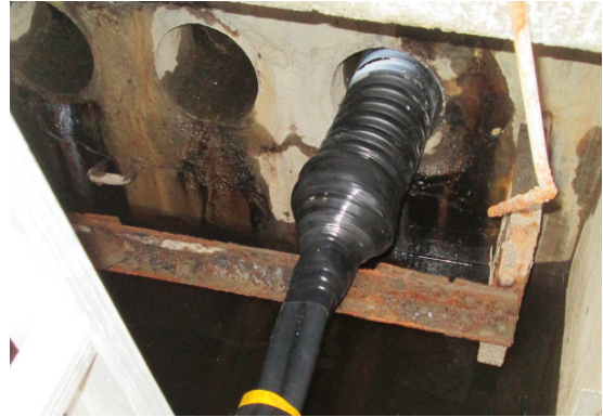
図3 保護管敷設及び止水処理状況
