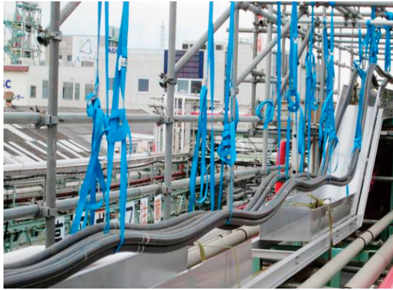
図1 既設ケーブル吊り上げ状況
