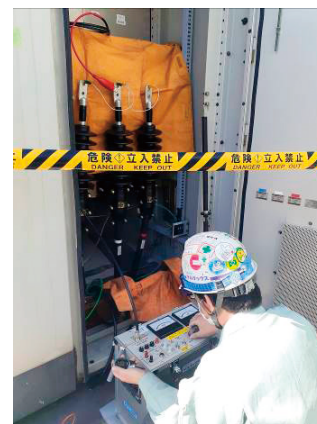
図7 絶縁耐力試験状況
