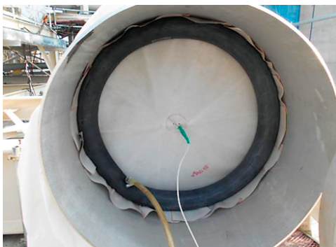
配管工事での適用
