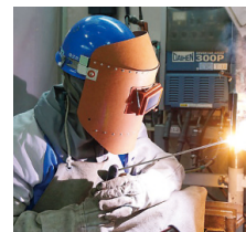
被覆アーク溶接
