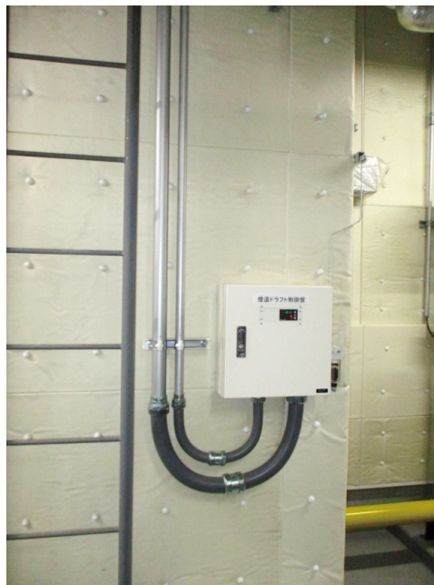
図4 盤下部への電線管接続状況
