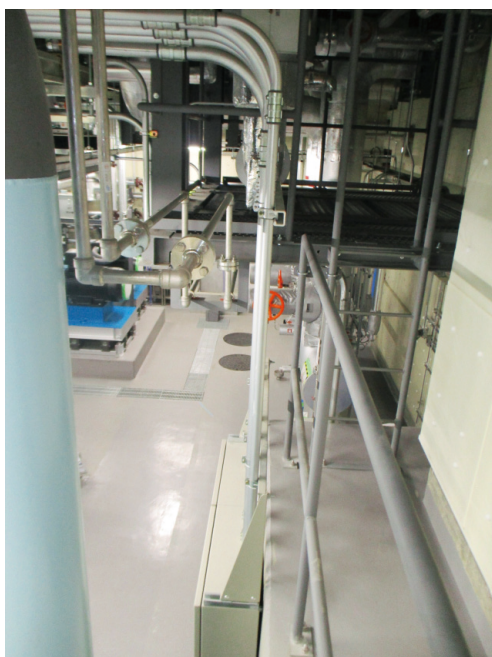
図3 盤上部への電線管接続状況
