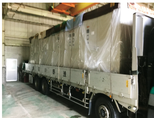
図5 搬入車両への盤積載状況
