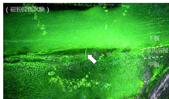
図9 底板に発生した応力腐食割れ
