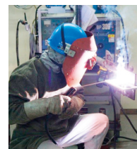
被覆アーク溶接
