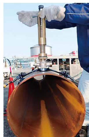
図2 穿孔作業の事前確認
