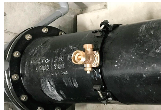
図6 サドル付分水弁取付け状況
