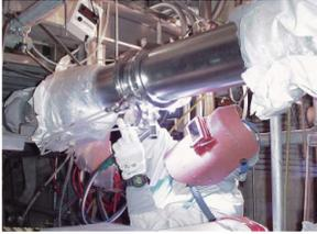
簡易溶接補助装置でチャージャーレベルのシールド雰囲気を実現
