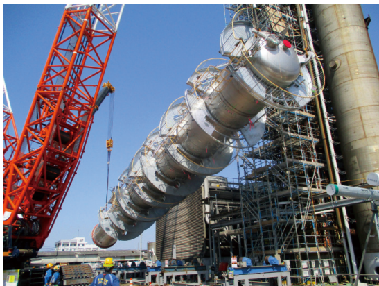
図8 吸収塔建て起こし
