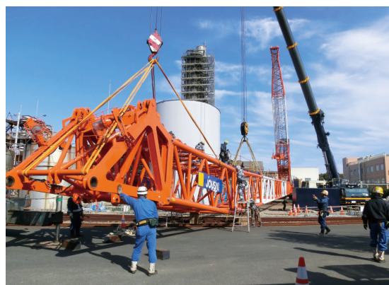
図5 500トンクローラー組立
