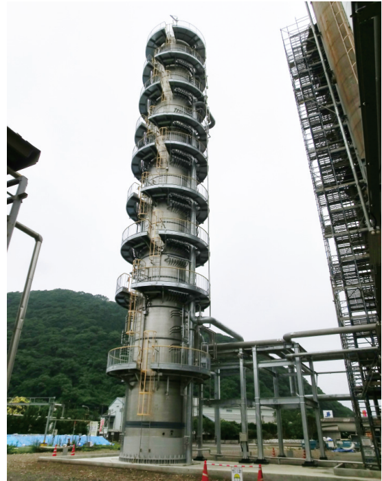
図9 工事完了写真
