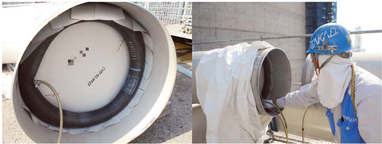
(a) 配管工事の状況
