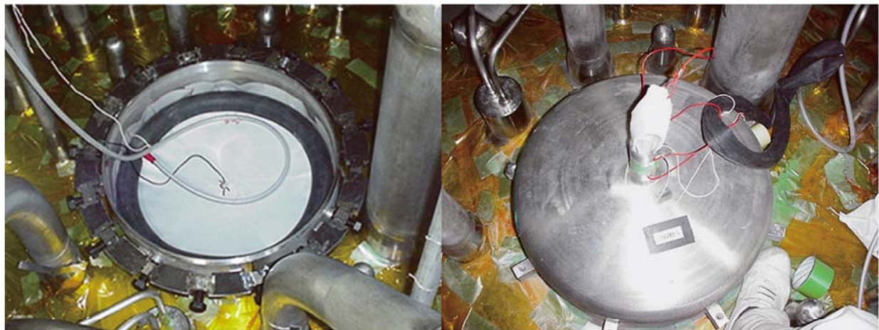
(b) 槽閉止工事の状況
