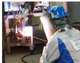
被覆アーク溶接
