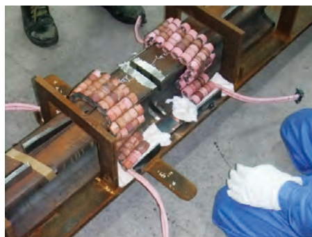
図5 コイルの設置
