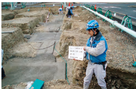
図3 建屋基礎掘削状況
