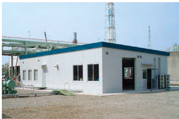
図 1 トレーニング設備建屋全景
