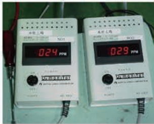
配管内部の酸素濃度測定 溶接治具内の酸素濃度測定
