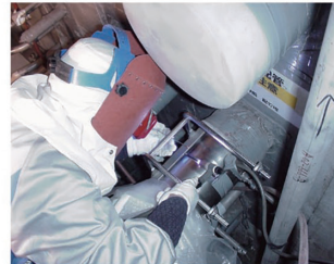
バックシールド治具セット 仮付け 仮付け検査
