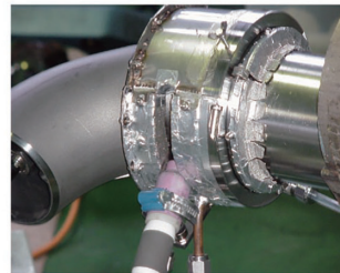
溶接治具のセット
