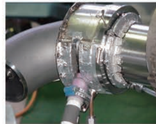
溶接治具のセット
