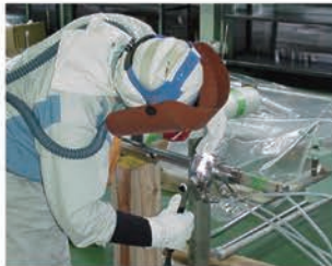
溶接 各パスの色調検査 最終層溶接 非破壊検査(RT・PT)
