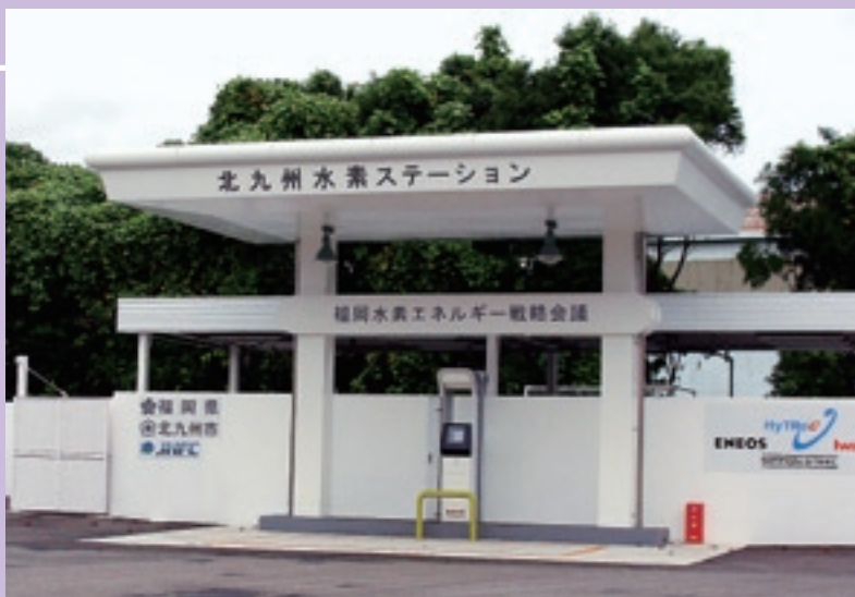
東田地区に建設された水素ステーション全景
