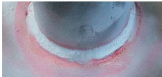
図9 低圧側インペラのボス部溶接線(溶接補修後再PT)
