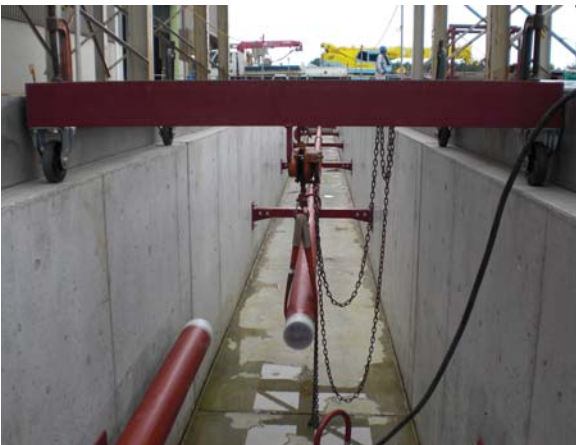
図3 配管敷設状況
