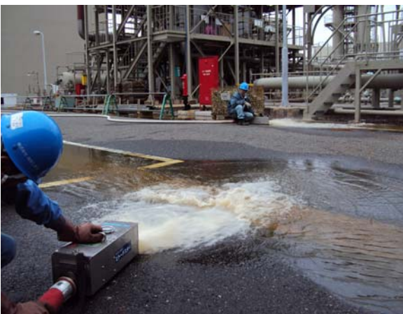
図2 放水試験状況
