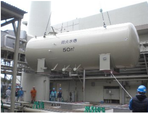
図1 防火水槽搬入状況
