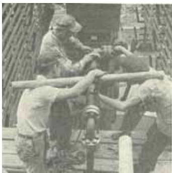
昭和28年、現場での配管作業
