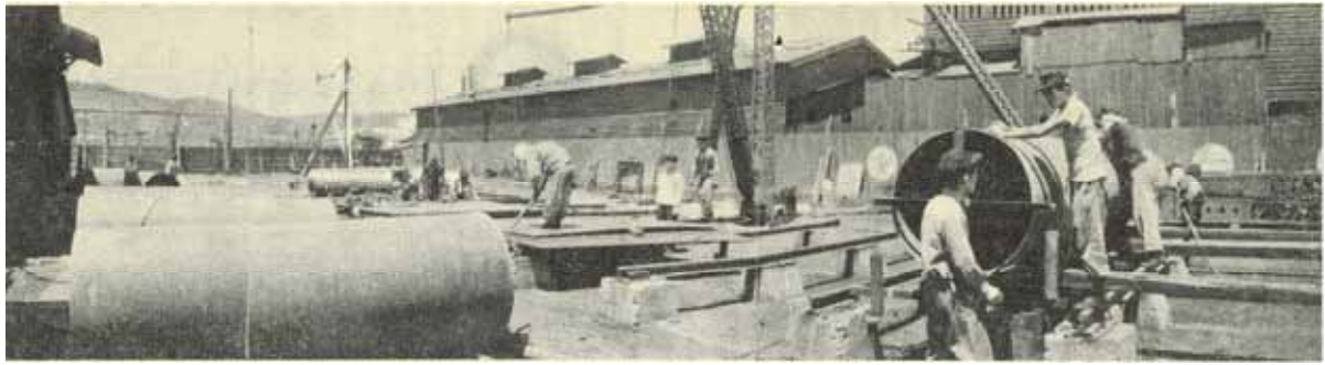
本社工場での製鉄関係の水道管製作工事の様子
