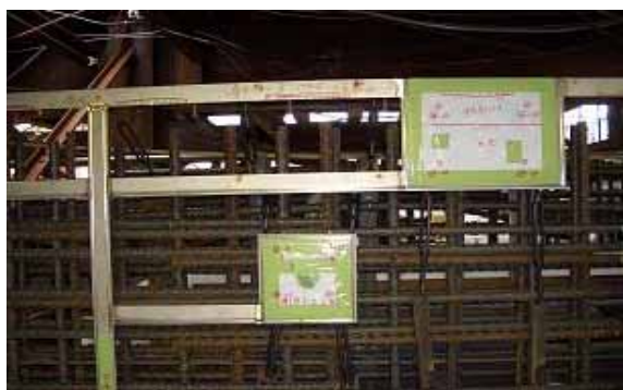
図2 埋込金物設置状況
