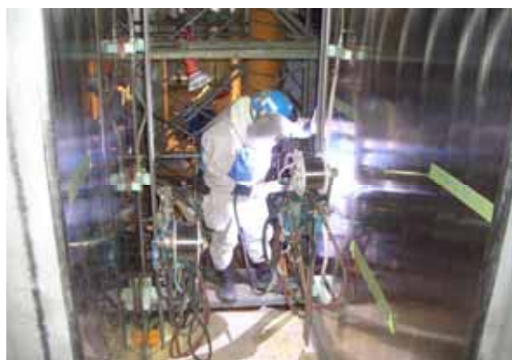
図4 ライニング板溶接（自動）状況
