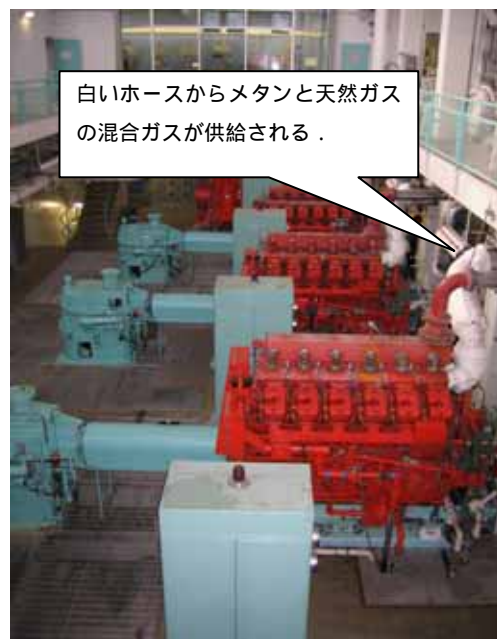
図2 送水動力用として用いられるディーゼルエンジン（米国ワシントン州シアトル市，2008/11/02）
