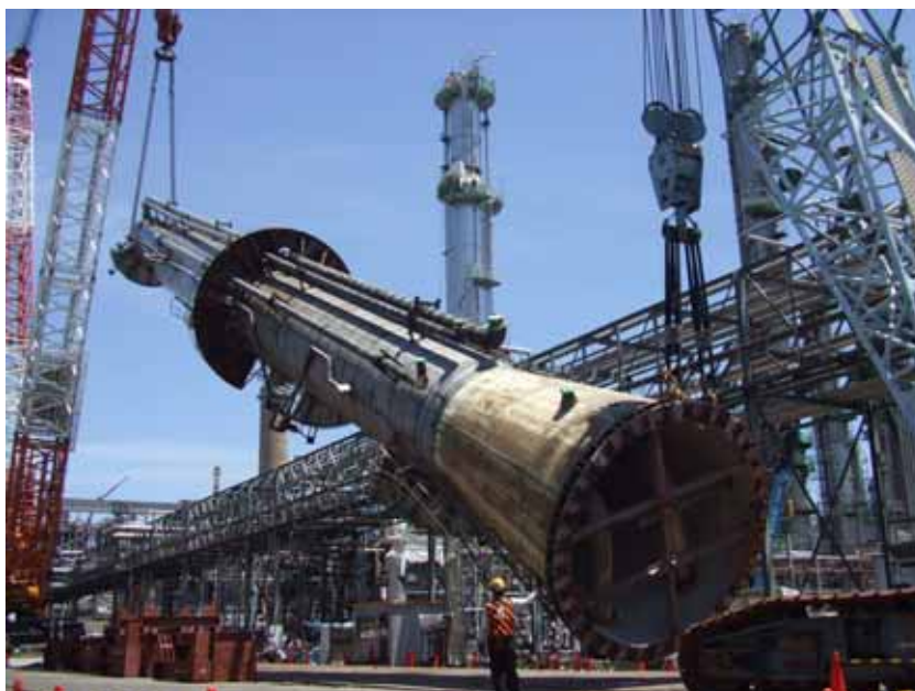
図 5 撤去中のタワー(背景に立っているのが今回据付けたタワー)
