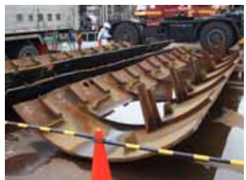
図 6 タワーの解体
