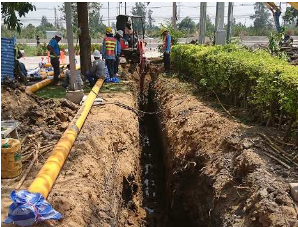
図5 Open cut 工法施工イメージ
