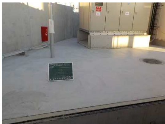
図5 コンクリート舗装
