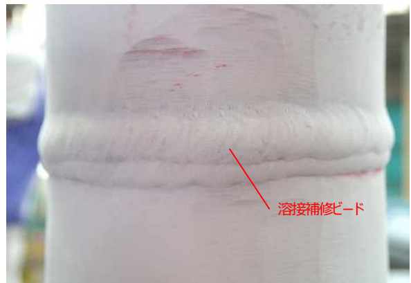
(a) 溶接後の浸透探傷試験の状況
