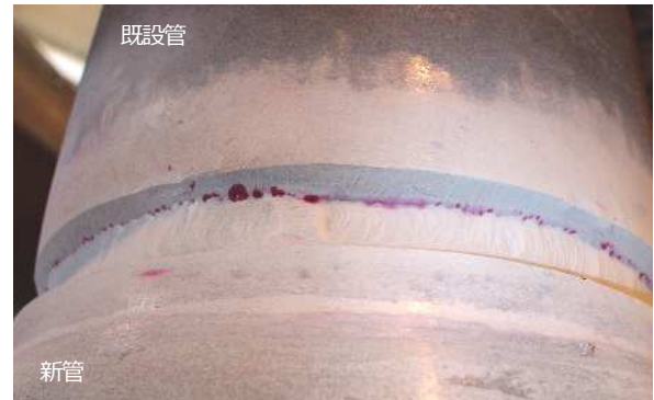
図11 連絡管の溶接後における浸透探傷試験の状況
